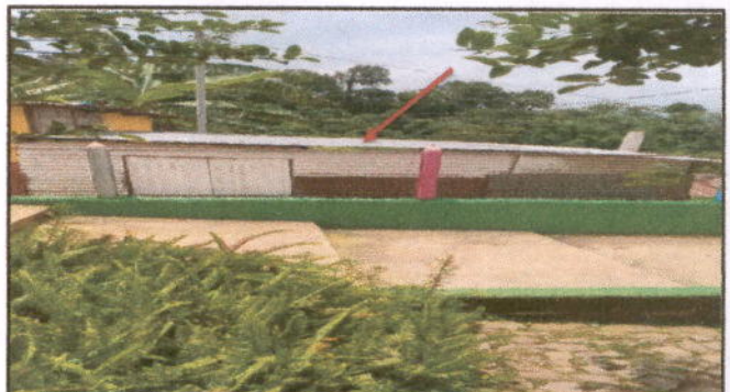
Foto 4: MÓDULO 3 COCINA CUBIERTA DE LÁMINA: Sustitución de lámina, por lámina troquelada aluzinc calibre 26, ESTRUCTURA DE TECHO: Mantenimiento a estructura de soporte de metal
