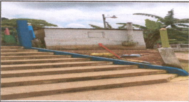
Foto 5: MÓDULO 3 COCINA Sustitución de muro de lámina por muro de block
